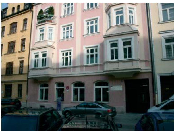
Die Umbauarbeiten für die neuen Räumlichkeiten des Kindergartens sind bereits im Gange.
